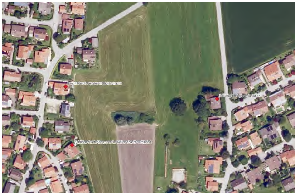
Abbildung 6.1: Auswertung Rückmeldungen Anliegerfragebögen hinsichtlich aufgetretener Schäden (Geobasisdaten: Bayerische Vermessungsverwaltung, 2024)
